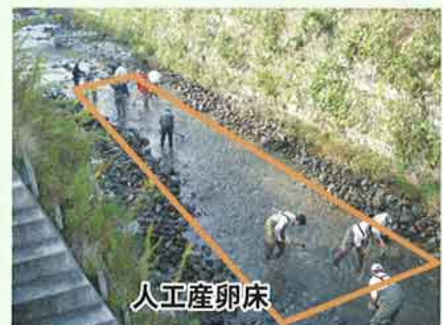
大きな石を取り除き、川底を耕うんして、礫を「浮き石状態」にする。
