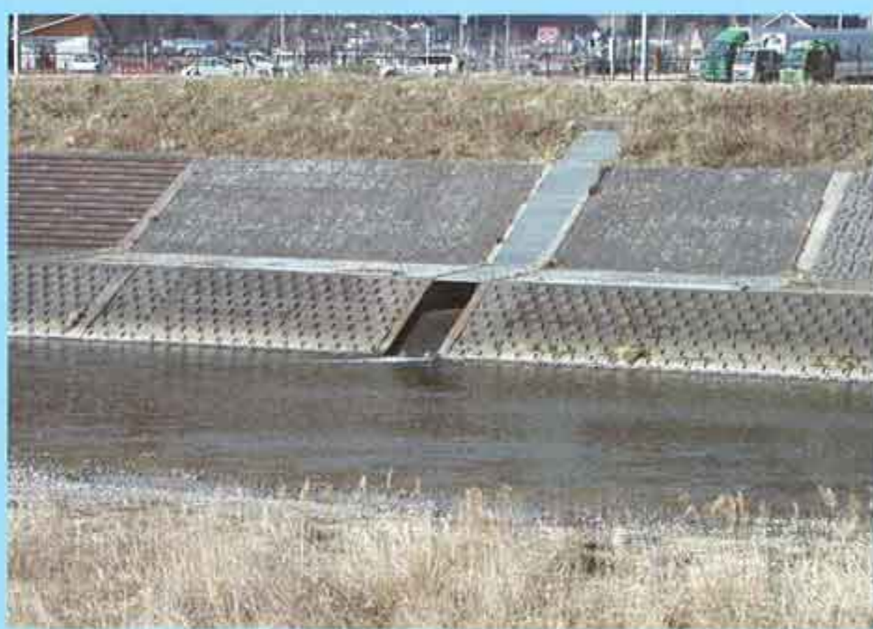
コンクリートで固められた川岸
